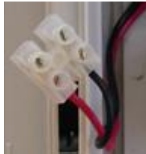
Рисунок 9. Кабель для подключения замка к блоку питания
